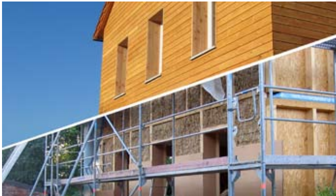
Baujahr 2006, Strohballengedämmter Holzrahmenbau, gemäß Z-23.11-1595
